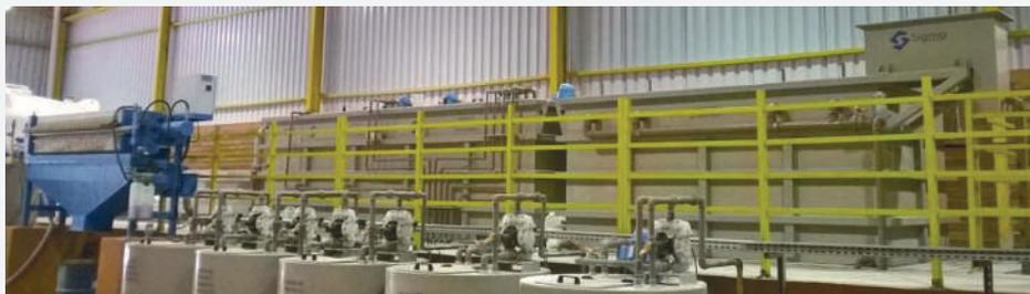
Um sistema de reciclagem de água com vazão de 4 m<sup>3</sup>/h também foi instalado. Assim, a geração de efluente e captação de água do poço foram reduzidas preservando os recursos naturais e gerando menos resíduos para o processo de tratamento dos efluentes.
