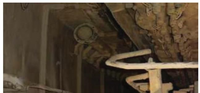
Figura 1: Incrustação de resíduos do processo de fosfatização
