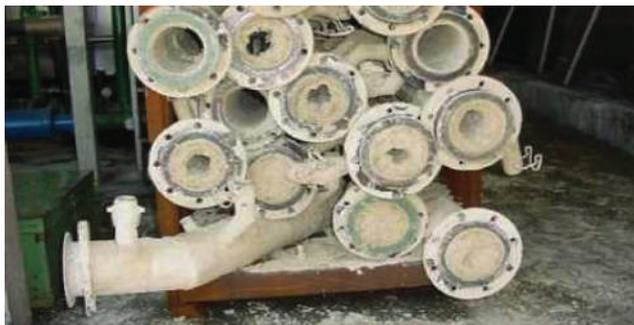
Figura 2: Incrustação de lama na tubulação
