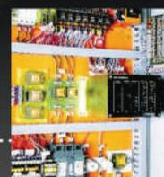
Sistemas de controle com cartões eletrônicos tipo "Euro-card plug-in" facilitam a instalação
