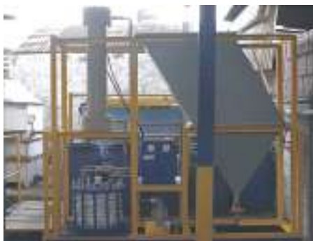
Figura 4 - Reator de eletrocoagulação-flotação de alta eficiência ECF-AE na ETEG da Termogal
