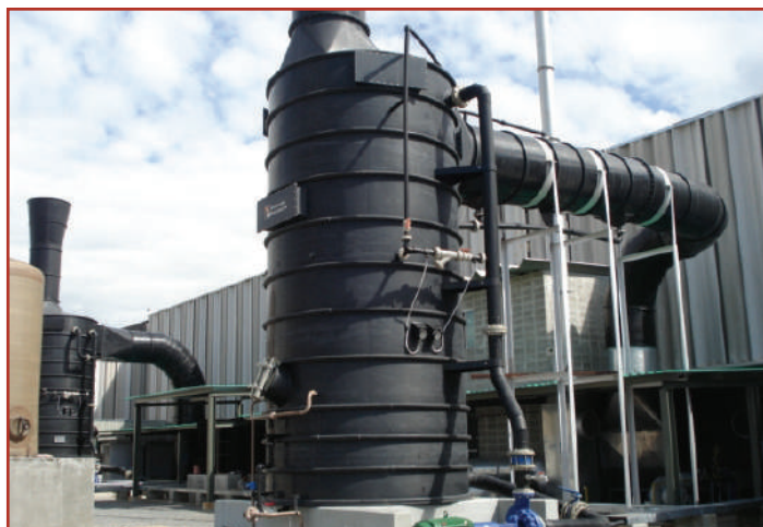
Um dos lavadores instalados na Incomisa
