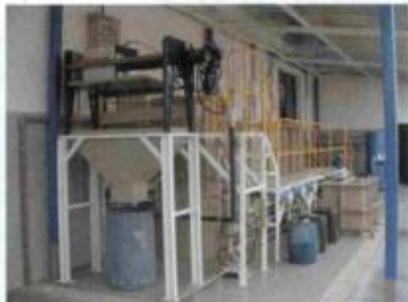
A desidratação do lodo gerado no sistema de tratamento é feita através de um filtro-prensa, capaz de reduzir o volume do lodo em até 20 vezes. Exemplo:
