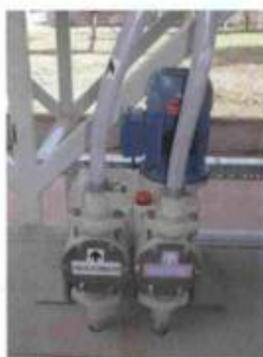
Os tanques de preparo e dosagem de produtos químicos da ETE são fabricados em polipropileno e são dotados de sistema de agitação por ar soprado, sensores de nível que acusam quando termina o produto, e bomba de dosagem automática.
