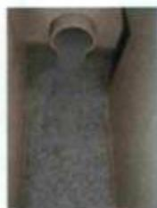
O clarificado sai continuamente por gravidade até o tanque elevatório de efluente tratado, de onde será recalcado para o filtro de polimento de efluente (filtro de areia, carvão e/ou zeólitos).
