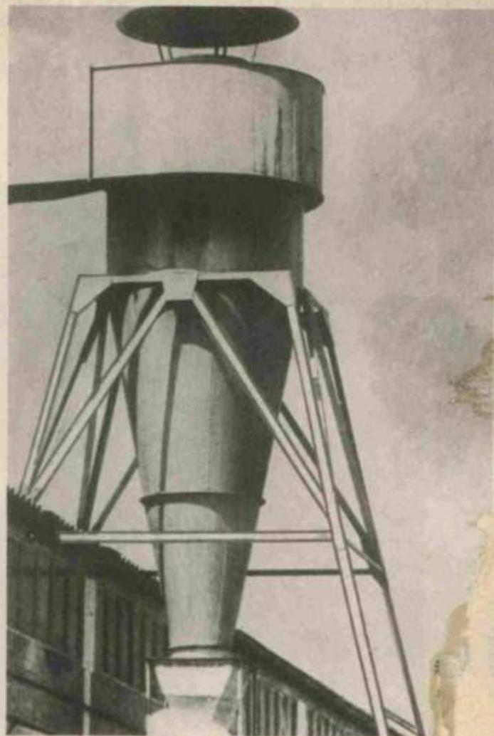
Ciclone para separação do pó e cavacos aspirados
