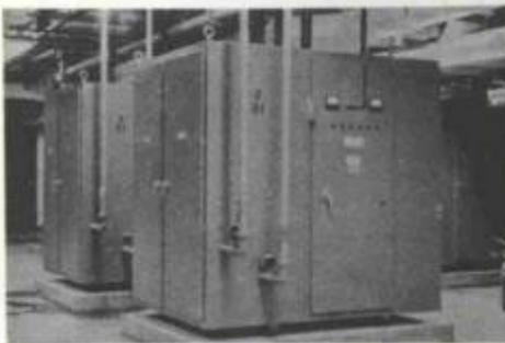
Retificador refrigerado a água e com diodos de silício e operado por um controle remoto. Consideração primária sobre um retificador para banho de cromo é "Baixo Ripple". Especificação fala em um máximo de 6% ripple na potência útil. Um alto ripple impossibilita a obtenção de depósito de cromo brilhante. A voltagem especificada em 9,12 ou 18 volts. A capacidade de corrente deve ser calculada entre 12 a 19A/dm<sup>2</sup> da área total a ser cromada em cada vez.
