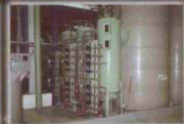
O Desmineralizador com regeneração automática
